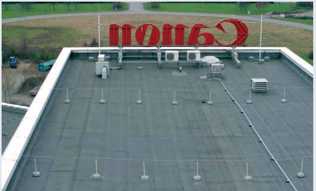
Смонтированная молниеприемная система с дистанционными держателями и бетонными основаниями
