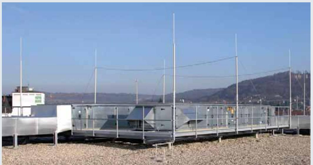
Изолированная система молниезащиты DEHNiso-Combi и HVI® проводник в изолированной трубостойке
