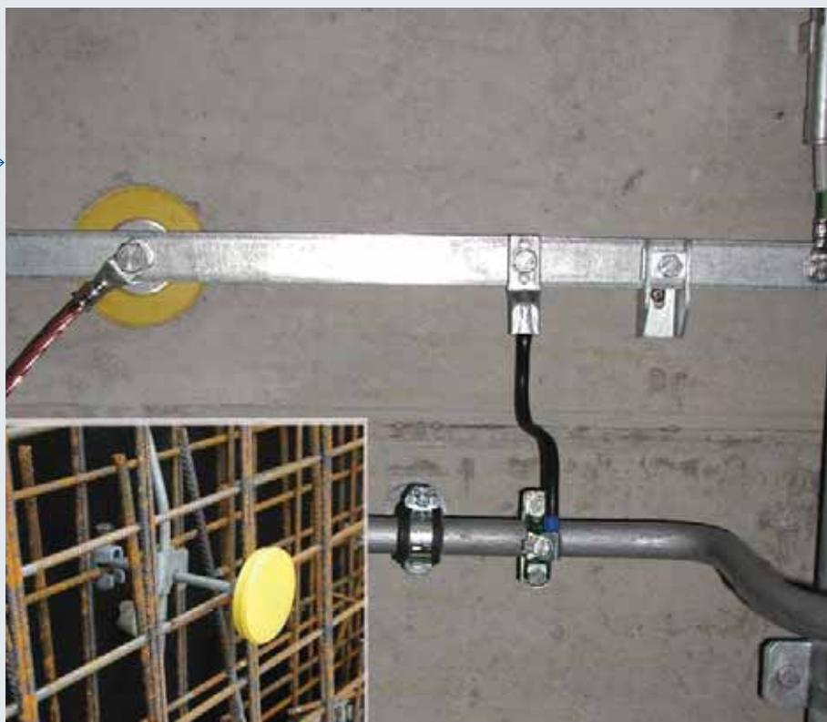
для соединения токоотводов со стержнями земляного ввода
