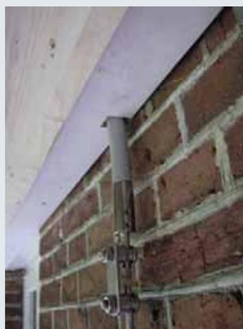
**Рис. 3:** Подключение к токоотводу – ввод проводника через карнизную доску
