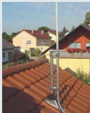
DEHNcon-H – изолированная трубостойка, смонтированная на стропильной балке
