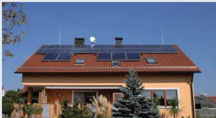
Изолированная система молниезащиты: все установки на кровле, в т.ч. солнечные термические установки, фотогальванические панели, дымоходы, параболическая антенна расположены в зоне защиты
