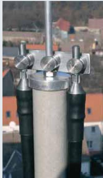
НВИ® проводник - параллельное подключение с помощью клемм
