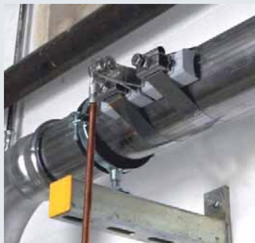
Рис. 2: Применение на трубе из нержавеющей стали
