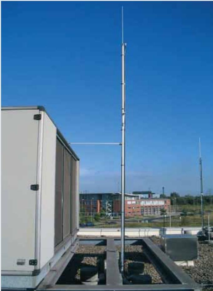
Изолированная система молниезащиты с НВИ® проводником, расположенная около надстройки на крыше.
