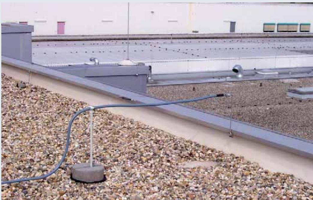
Зона концевой заделки проводника HVI® light в месте присоединения к металлическому аттику
