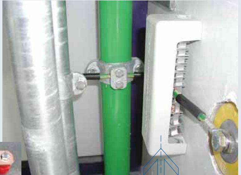
Шина уравнивания потенциалов с подключением к фиксированной точке заземления
