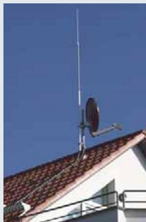
Фрагмент – Изолированная трубостойка с проложенным токоотводом
