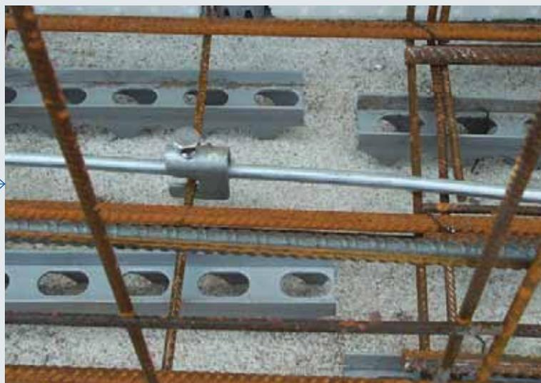
Заземление для строительного силового распределительного щита
