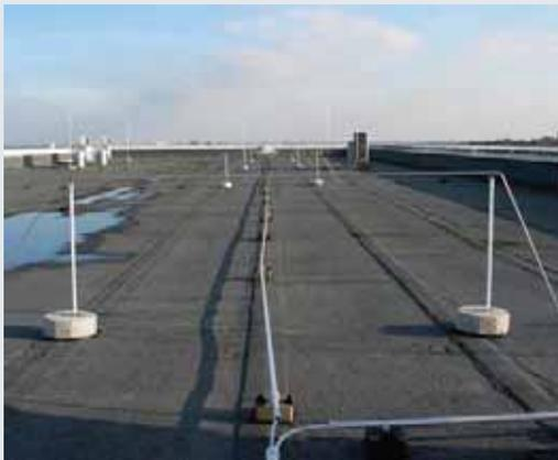
Молниеприемная система с дистанционными держателями и бетонными основаниями, установленная в зоне прокладки электропроводки на кровле
